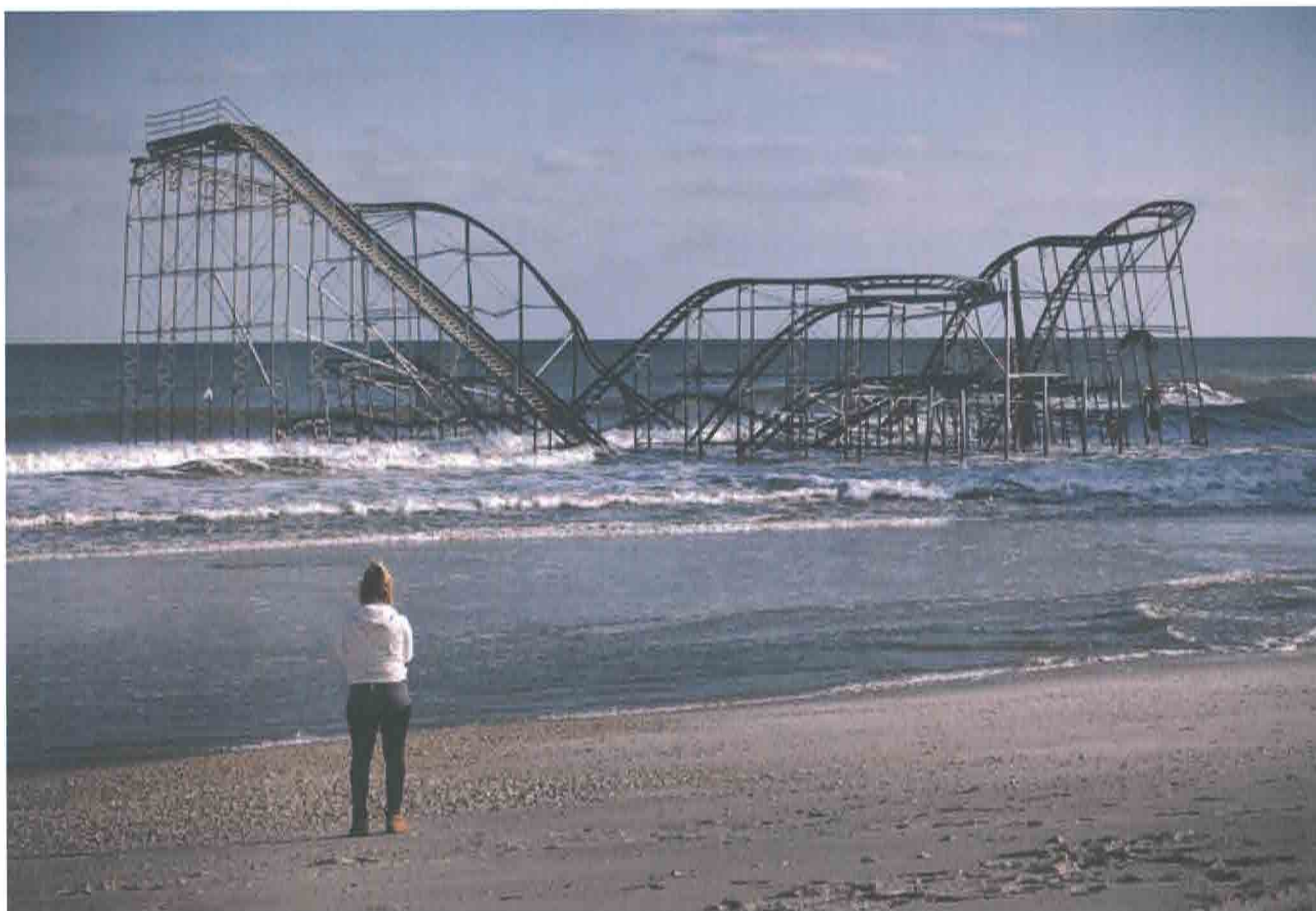
Foto: En rutsjebane ved New Jerseys kyst, USA. Konstruktionen, den stod på, kollapsede under superstormen Sandy i 2012. Credit: Scanpix
